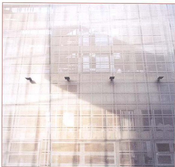
Istočna fasada rezidencije
